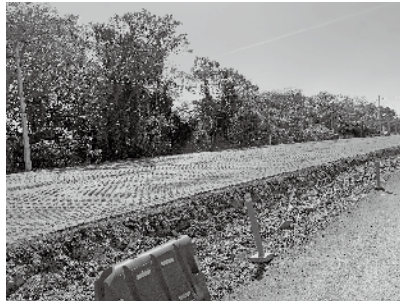
写真5 幹線道路の複線化工事が進む(コロンネ・オビエドにて筆者撮影)
