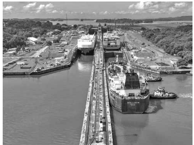
写真1 カリブ海側の旧閘門「ガッソ閘門」に入るパナマックス船。3段の閘門を上ると「ガッソ湖」（運河庁提供）
