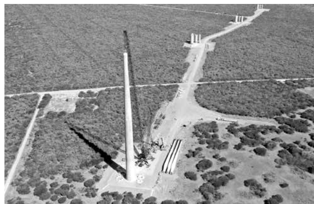
写真3 陸上風力発電所（第 1 期計画）TEB。風車 PC タワー組立状況
