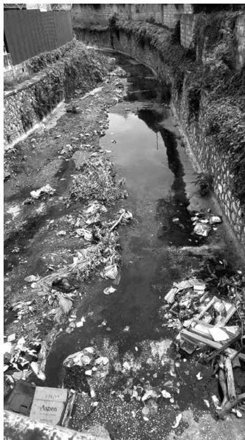
写真1 現地で Gully と称される雨水排水舗装路 (JICA ジャマイカ支所岡崎裕之撮影)
