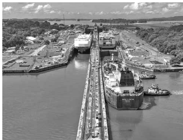
写真1 カリブ海側の旧閘門「ガッソ閘門」に入るパナマックス船。3段の閘門を上ると「ガッソ湖」（運河庁提供）
