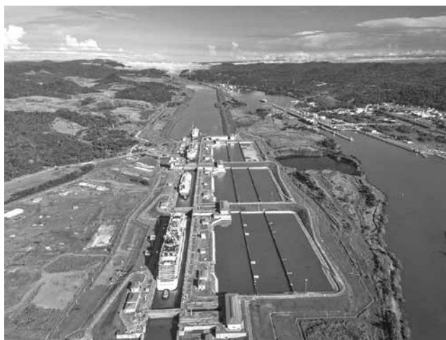
写真2 太平洋側の「ミラフローレス閘門」と「ペドロミゲル閘門」(写真右上方)を迂回する形の「ココリ閘門」を3隻のネオパナマックス船が太平洋に向けて移動中。各閘門には大型ブール風の3面の節水槽(運河庁提供)
